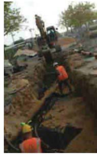
La rénovation des réseaux des eaux usées est relancée.
